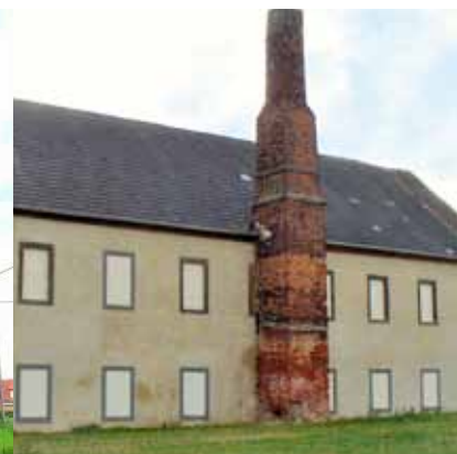
Bauzustand heute: Der Schornstein folgt demnächst...
